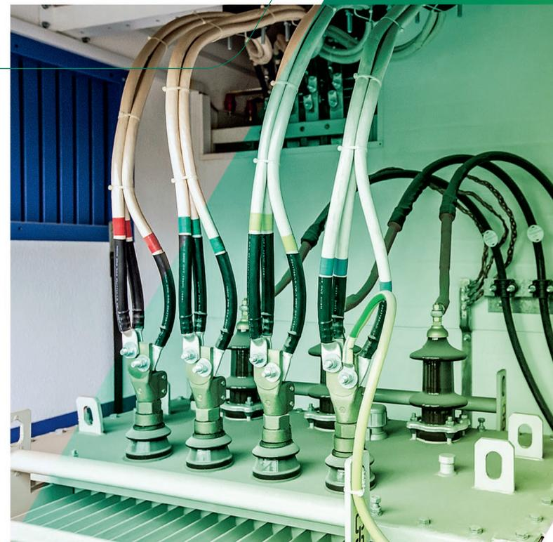
Соединение РУВН с силовым трансформатором выполняется одножильными кабелями, которые подводятся к электрооборудованию через отверстия в панели пола. Подвод кабеля к выводам трансформатора осуществляется сверху и предотвращает возможность их деформации. Соединение РУНН с силовым трансформатором может выполняться одножильными кабелями или шинами. Кабели прокладываются в кабельных лотках или закрепляются с помощью крепежных деталей.
