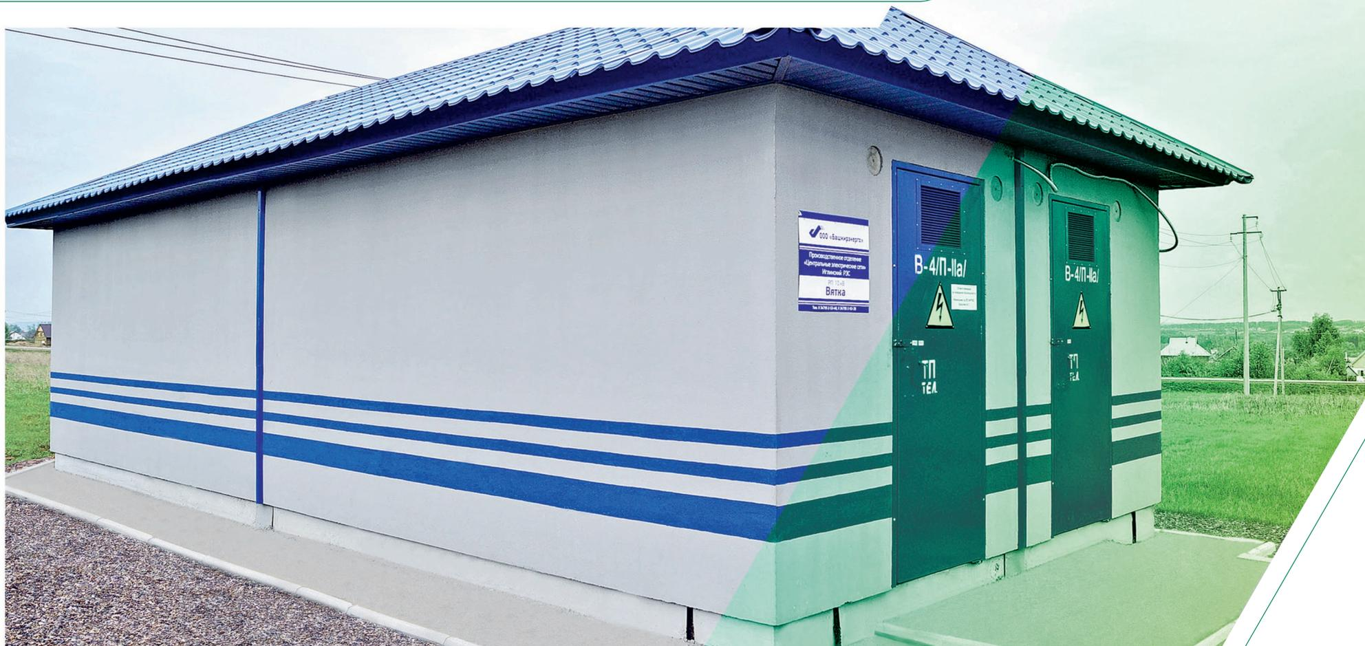
Здание подстанции комплектуется из функциональных блоков РП и ТП. В блоках РП размещается РУВН 6(10) кВ, а в блоках ТП — силовые трансформаторы и РУНН 0,4 кВ.
