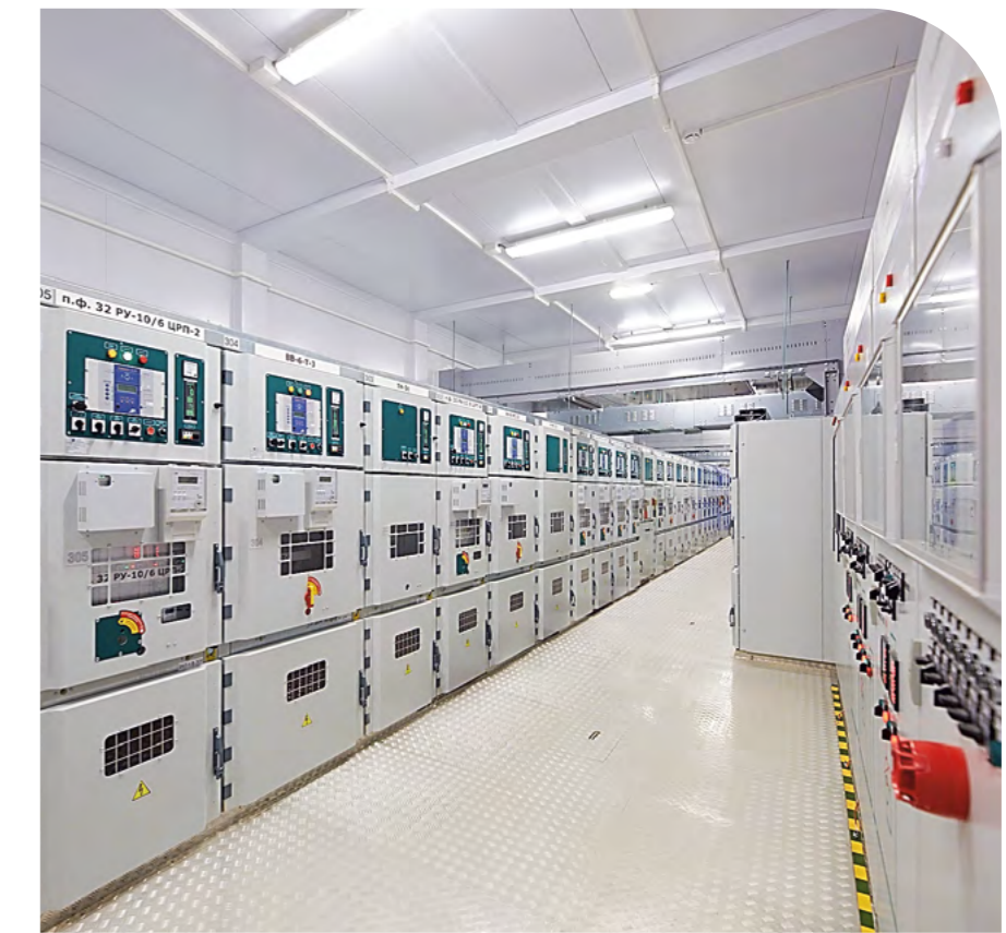
Двухрядное ЗРУ 6 (10) кВ с ячейками серий «КРУ-ТЭС», совмещенное с ОПУ
