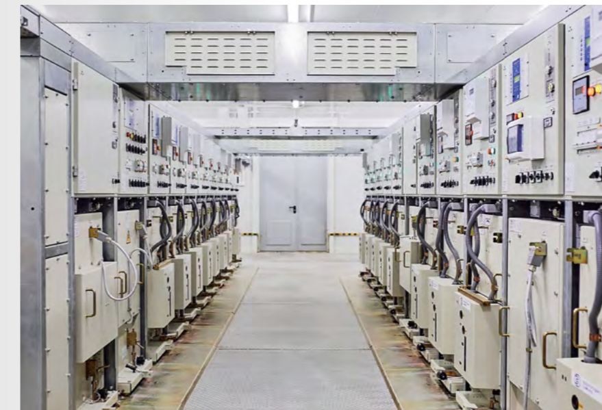
Двухрядное расположение КРУ серии «К-104» в КРУМ 10 кВ
