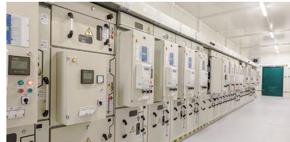
Однорядное расположение КСО «Новация» со средним вкатом в КРУМ 10 кВ
