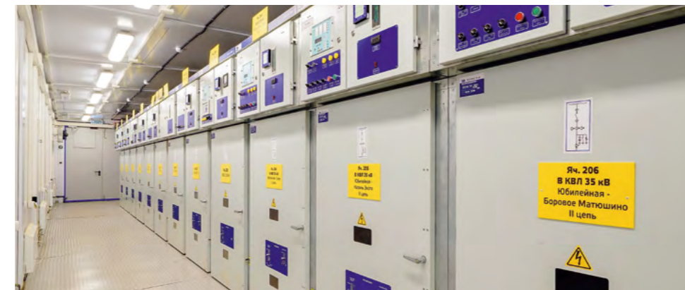
КРУМ 35 кВ с однорядным расположением ячеек ИРИС с нижним вкатом
