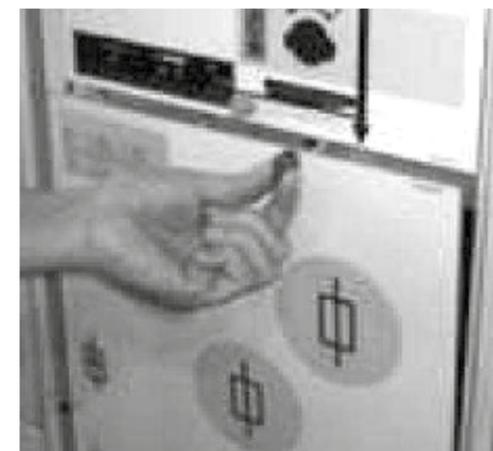
2) Используя ручку управления, поворачивая ее против часовой стрелки, открыть блок предохранителей.
