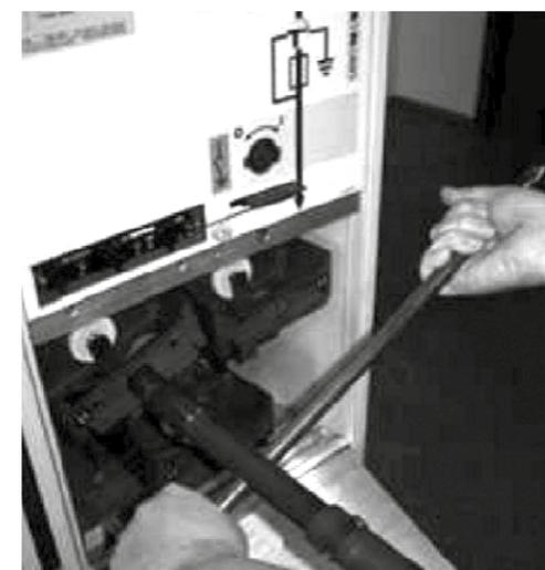
3) Вытащить блок предохранителей, потянув за ручку. Предохранитель плотно закреплен на торцевой крышке блока и вынимается вместе с ним.
