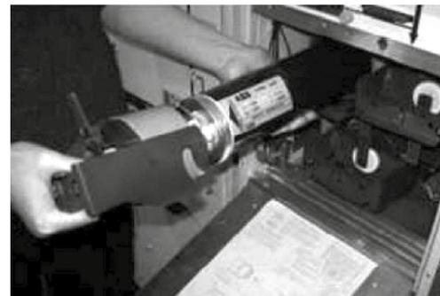
4) Закрепить новый предохранитель на торцевой крышке блока предохранителей с помощью крепежных винтов. Ударник должен быть направлен наружу, чтобы предохранитель мог нормально работать.
