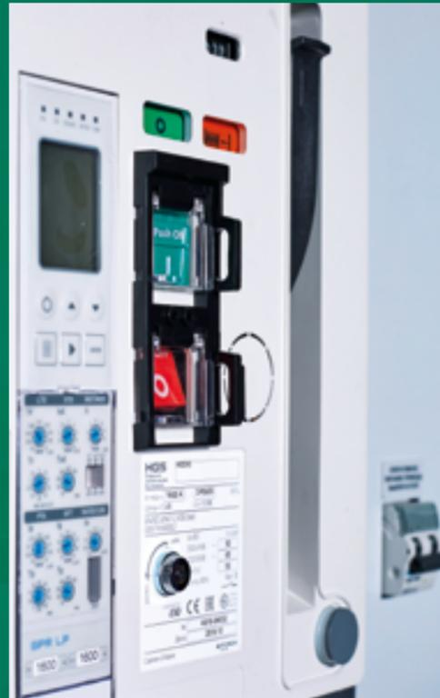
Рис. 4.16. Автоматический выключатель с микропроцессорным расцепителем
